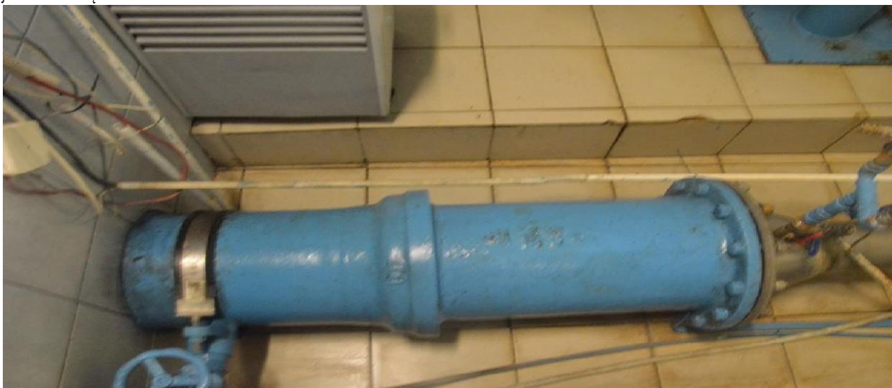
Zdjęcie 18 – powyżej przedstawia istniejący wodociąg DN 250 z żeliwa z 1937 roku, którego dwie pierwsze kształtki są jeszcze umiejscowione w budynku technologicznym. Następnie instalacja to przebiega przez K1 z rozdziałem do w kierunku K3 i dalej wodociągiem DN 250 do miasta z K1 jest również na trójniku rozdzielony do K2.
