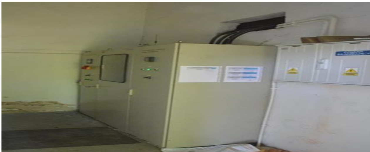
Zdjęcie 34 – powyżej przedstawia widok Rozdzielnicy RGII w budynku stacji trafo – wnętrze komory rozdzielni nn
