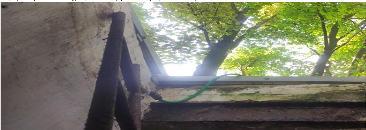
Zdjęcie nr 24 powyżej – Strop Komory przelotowej K-3 – w miejscu wjazdu technicznego do komory na styku strop wylewany na mokro a nadbudowa ceglana stropu.
