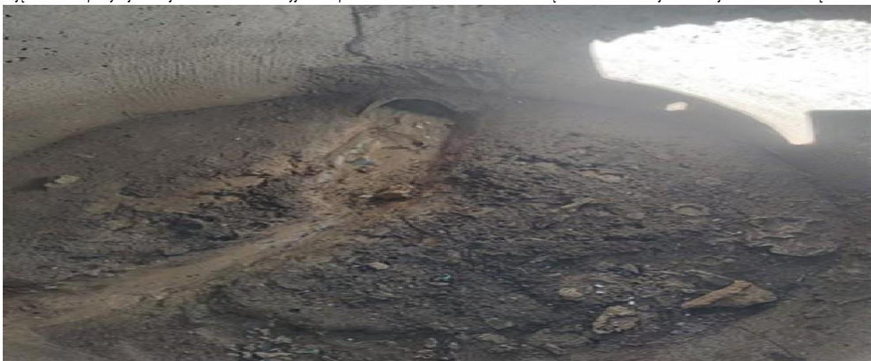
Zdjęcie nr 31 – powyżej studzienka kanalizacyjna z odprowadzeniem ścieków z chlorowni włączona do kanalizacji sanitarnej – widok wewnętrzny – w studzience do wysokości kiny zalega osad, który powoduje brak drożności i zapiaszczenie dalszego odcinka kanalizacji. Widoczny wylot ze studzienki jest praktycznie cały wypełniony osadem.
