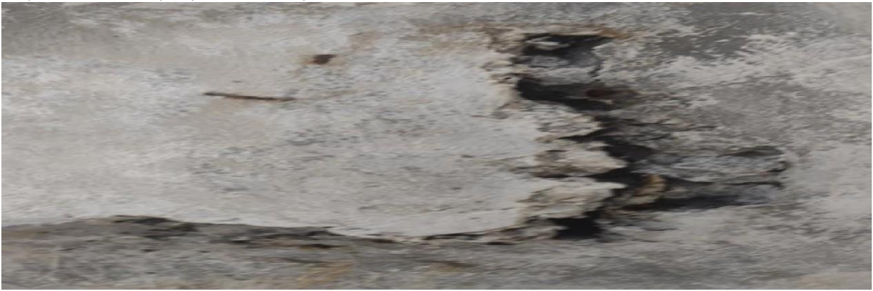
Zdjęcie nr 23 powyżej – Strop Komory przelotowej K-3 – w wyniku przecieków, występujących naprężeń oraz cykli zamarzania i odmarzania wody z przecieków w stropie powstały widoczne na zdjęciu punktowe odspojenia znacznych powierzchni stropu.
