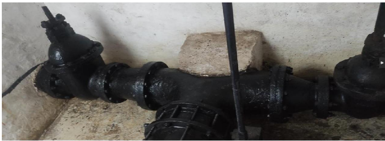
Zdjęcie nr 17 – powyżej przedstawia Komora Zasuw – K1 - Węzeł technologiczny w Komorze K1 jest pokryty dla utrzymania estetyki kolejnymi warstwami farb, również na połączeniach kołnierзовych i śrubunkach, co w przypadku awarii będzie dużym utrudnieniem do jej usunięcia zwłaszcza w warunkach bardzo trudnych i niespodziewanych, jakimi właśnie są awarie.
