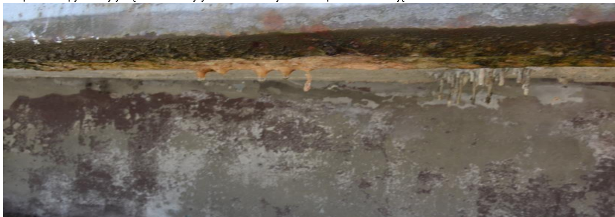
Zdjęcie nr 7 powyżej przedstawia widok nacieków stalaktytowych pod rampą budynku magazynowego.
