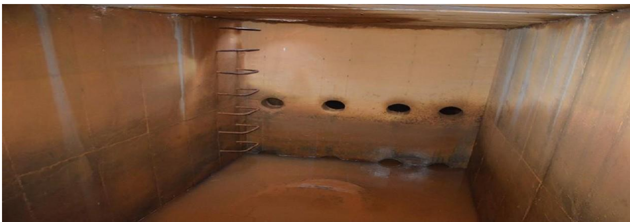
Zdjęcie nr 27 – powyżej – Zbiornik popłuczyn – K 4. Komora przepływowa
