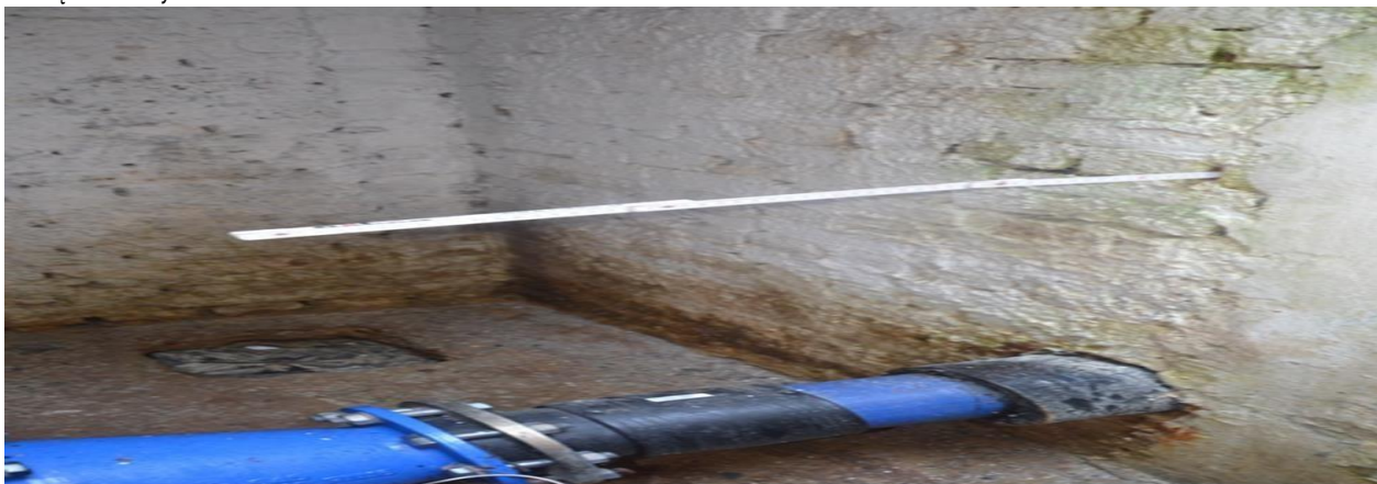
Zdjęcie nr 21 – powyżej – Wnętrze komory zasuw K-2 przedstawia zastosowanie różnych materiałów instalacji technologicznej od rury PE z nieszczelnym przejściem przez ścianę w rurze osłonowej z PEHD; nowa zwężka z żeliwa oraz dalej są zamontowane stare kształtki z żeliwa jak w K-1.
