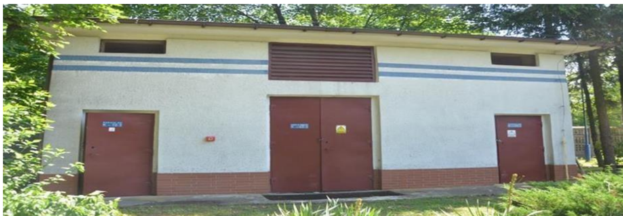
Zdjęcie nr 33 powyżej przedstawia budynek stacji trafo drzwi po lewej stronie wejście do pomieszczenia komory nn – własność Zamawiającego. Drzwi / wrota środkowe – komora 15/0,4 kV – własność PGE; drzwi z prawej strony komora SN – własność PGE.
