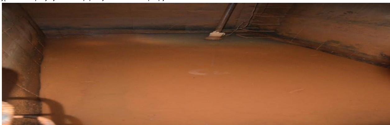
Zdjęcie nr 28 – powyżej – Zbiornik popłuczyn – K 4. Komora odpływowa z której woda jest przepompowywana jest do stawu technologicznego.
