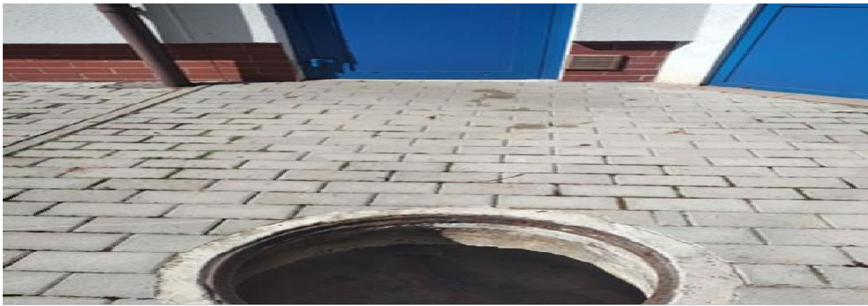
Zdjęcie nr 30 – powyżej widniej studzienka kanalizacyjna z odprowadzeniem ścieków z chlorowni włączona do kanalizacji sanitarnej – widok zewnętrzny.
