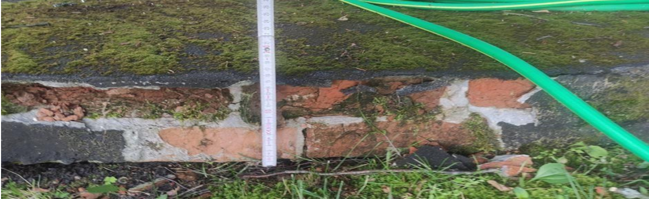
Zdjęcie nr 22 powyżej – Nadbudowa stropu komory przelotowej K-3 wykonana z dwóch warstw cegły pełnej na zaprawie cementowo – wapiennej i pokryta warstwą papy na lepiku. Całość nadbudowy w złym stanie technicznym.
