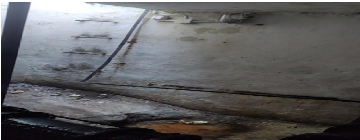
Zdjęcie nr 16 powyżej: Komora Zasuw – K1 - dno bardzo nierównomierne na całej powierzchni ( brak jakiejkolwiek płaszczyzny ) ściany, strop część wewnętrzna, stopnie zejściowe w przypadku tej komory są niebezpieczne do zejścia dla obsługi i prac serwisowych są odsunięte od ściany tylko ok. 10 cm przy standardowych jest to ok. 25 cm.
