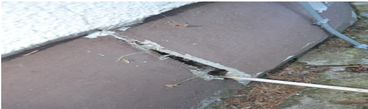
Zdjęcie nr 8 powyżej przedstawia destrukcyjny wpływ zarówno bliskości drzewa, które przez 30 lat urosło do bardzo dużych rozmiarów i destrukcyjnie wpływa na elewację oraz fundamenty i ścianę budynku oraz braku prawidłowego odprowadzenia wód deszczowych z dachu.
