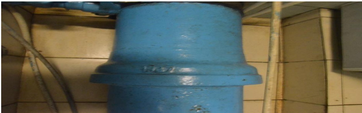
Zdjęcie 19 – powyżej przedstawia istniejący wodociąg DN 250 z żeliwa z 1937 roku którego dwie pierwsze kształtki są jeszcze umiejscowione w budynku technologicznym – widoczny cech własny rury z 1937 roku. Połączenie między tymi dwoma kształtkami na tzw. szlamunek tj. nabijany sznur łojowy a następnie konopny suchy. Po wykonaniu czynności związanych z ubijaniem sznura wykonywało się z gliny obwiednie po obwodzie rury a do góry pozostawiało się otwór do wypełnienia całości i uszczelnienia gorącym ołowiem, który po wystygnięciu tworzył trwałe uszczelnienie.
