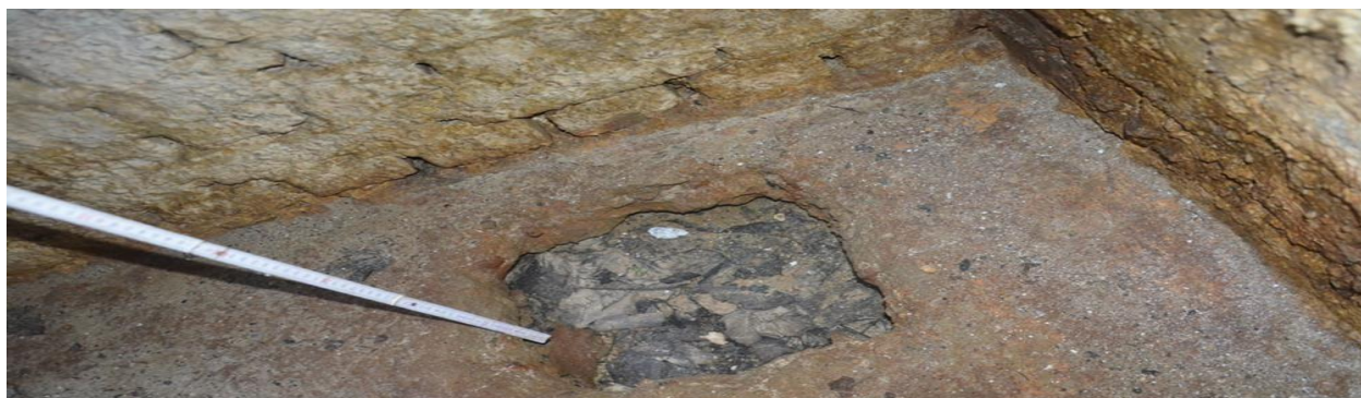
Zdjęcie nr 20 – powyżej – Wnętrze komory zasuw K-2 przedstawia otwór chłonny w dnie, przez który może nachodzić woda gruntowa. Powyższe rozwiązanie wypłukuje grunt pod dnem. Samo dno ma grubość mierzoną w tym miejscu ok. 12 cm. Ściany ceglane z widocznymi ubytkami w spoinach, które drenują wodę gruntową i opadają do wnętrza komory
